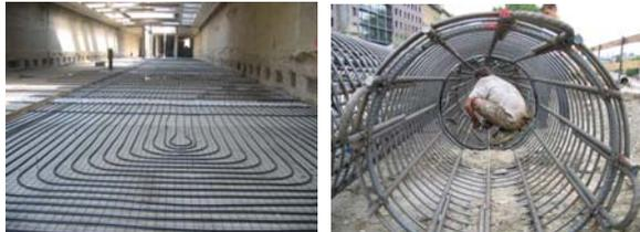
Abbildung 1: A: Absorberleitungen für eine Energiebodenplatte.
