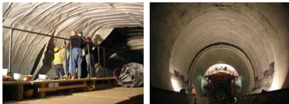
Abbildung 2: Einbau des Energievlieses in einem Testabschnitt des bergmännisch aufgefahrenen Lainzer Tunnels
